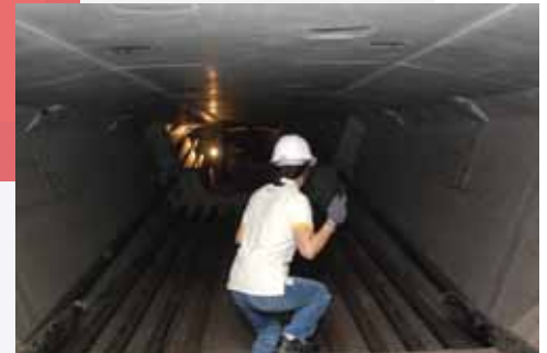
การตรวจสอบการกัดกร่อน ในระบบขนส่งมวลชนทางราง
